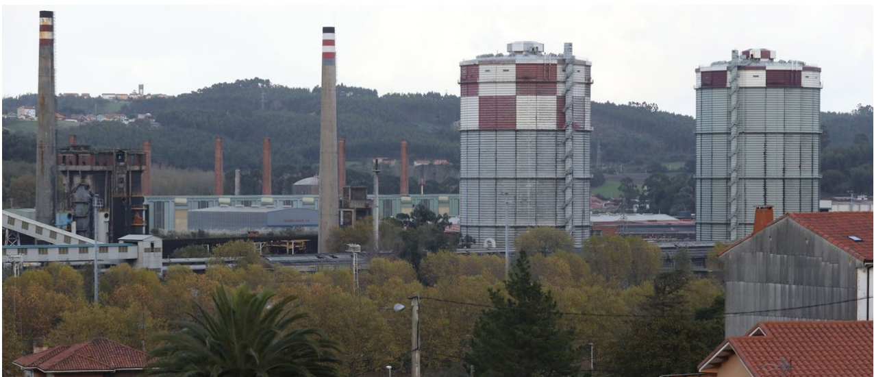
Instalaciones de las baterías de coque de Ensidesa. Mara Villamuza
