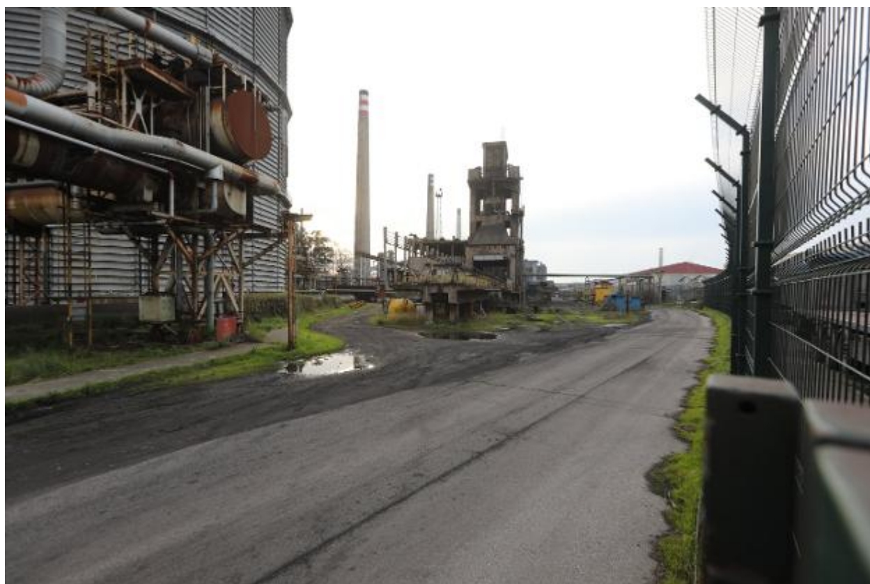
Uno de los gasómetros, en primer plano con una de las baterías al fondo. / MARIETA
